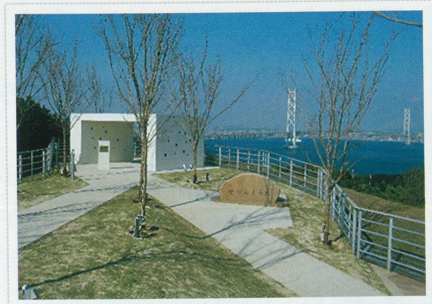
「恋人の聖地」淡路SAモニュメント・遊歩道設置工事
