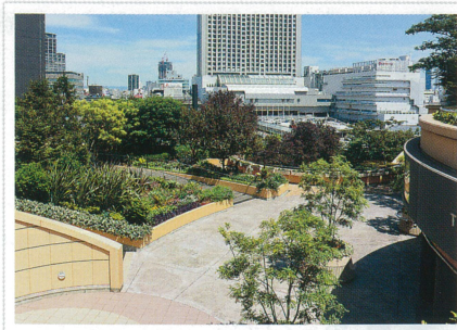
なんばパークス屋上緑化植栽工事
