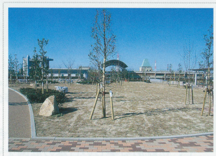
寝屋川流域下水道鴻池水みらいセンター 植栽工事
