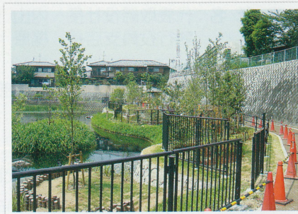
吹田市水辺新設工事
