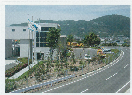
阪和自動車道 有田地区造園工事
