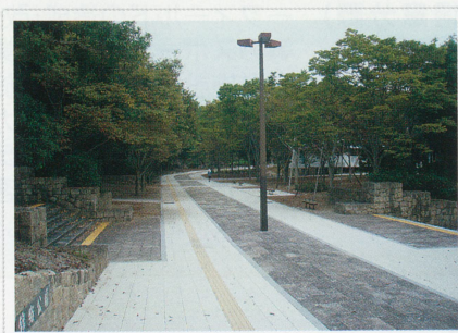
大阪府錦織公園石畳の里改修工事
