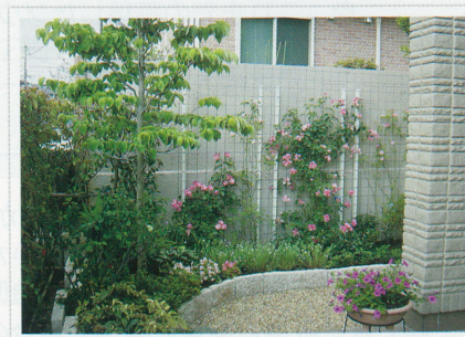
個人邸花壇設置工事
