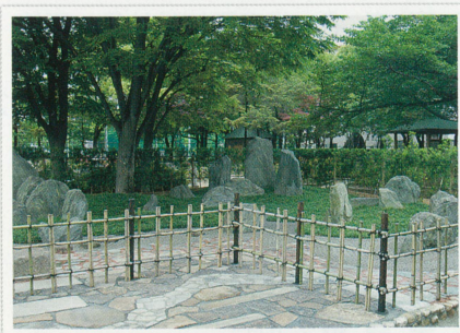
重森三玲作庭庭園移築工事 (泉大津市東雲公園)
