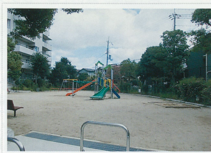
公園リニューアル工事
