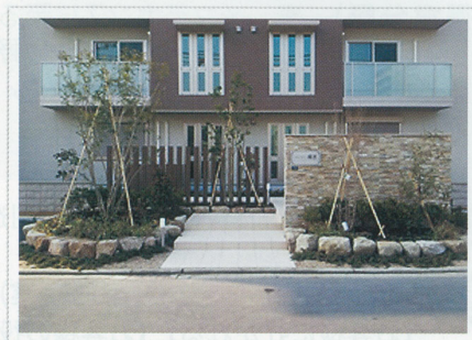
(仮称) 八尾市・シャーマゾン大北邸 新築工事
