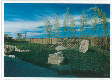
某企業京都工場の造園工事①
