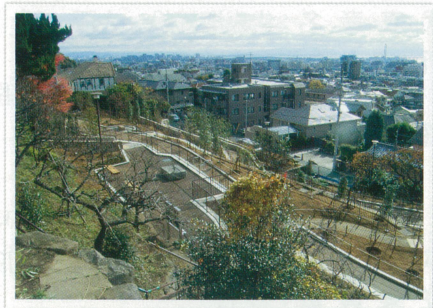
岡本公園拡張地整備工事
